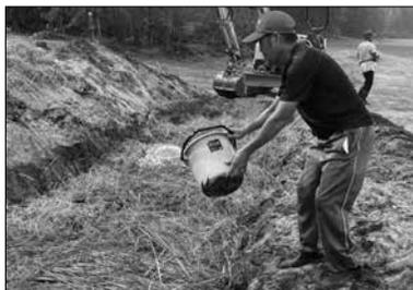
刺竹削平後先埋在海沙後先舖上野草，再用海水淋濕，並等待大漲潮時淹沒竹管，使竹管變輕並可防蟲。
